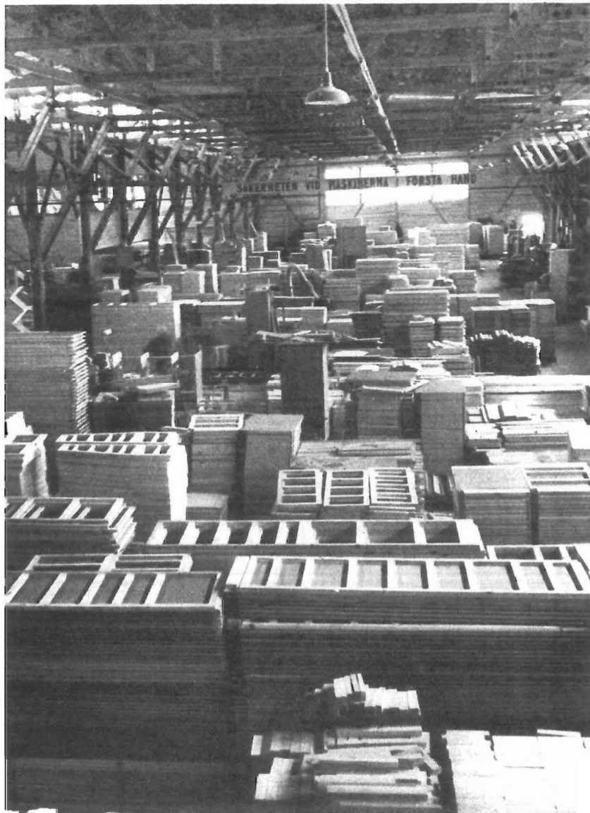
Depuis une dizaine d'années, la construction des maisons pré-fabriquées de bois s'est développée de plus en plus. Les usines de menuiserie fournissent également portes et fenêtres aux autres constructions. Photo: Foto-Hernried.
