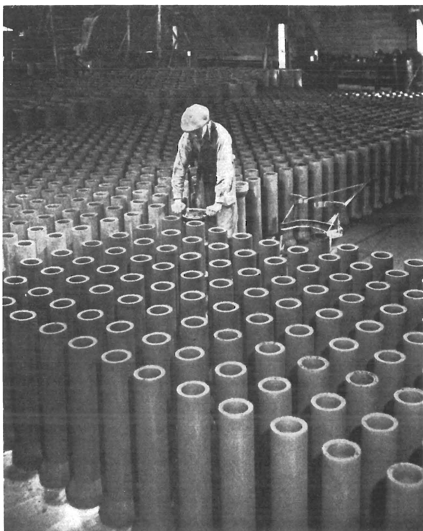
Les besoins de la Suède en tuyaux d'écoulement et de drainage ont provoqué un développement rapide de l'industrie des matériaux en ciment, dont le marché et la production se sont montrés accessibles à beaucoup de petites entreprises. Photo: Inge Holm.
