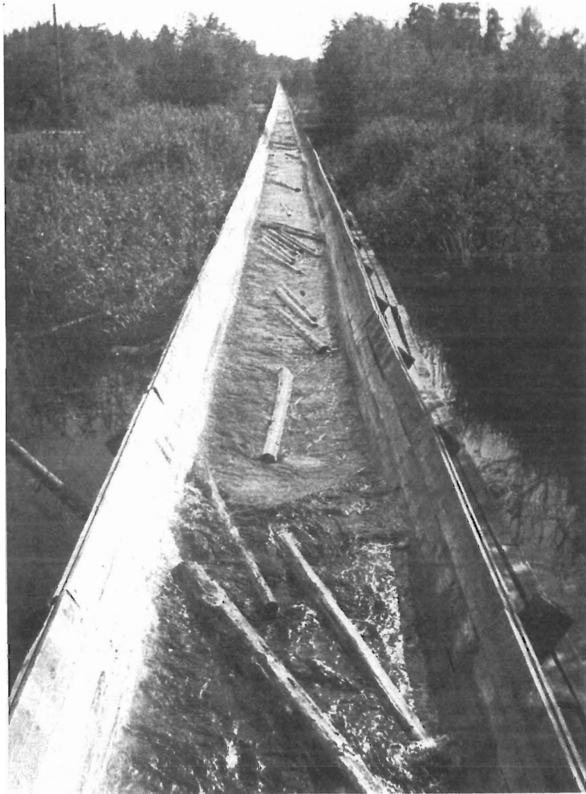
Des zones d'exploitation aux usines, situées pour la plupart sur la côte, les troncs sont transportés par voie fluviale. Dans les endroits où ce flottage présente des difficultés, on a construit des canaux spéciaux pour l'acheminement des troncs. Photo: K. G. Kristoffersson.
