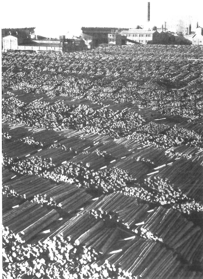
Les chantiers où se faisait le séchage des bois de scierie ont été longtemps une caractéristique des agglomérations du Norrland. Les installations de séchage mécanique les font disparaître peu à peu. Photo: Stora Kopparberg.
