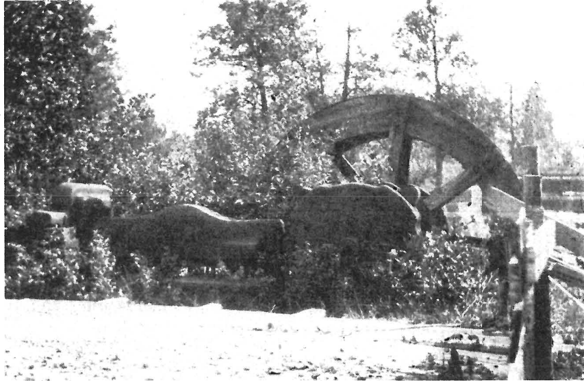
Vattenhjul med stångjärnshammare från 1600-talet. Fotot är taget vid Bofors år 1928.
