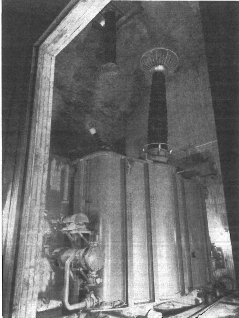
Einer der vier Einphas-Transformatoren in der grossen hydroelektrischen Anlage bei Harspränget. Die Transformatoreneinheiten haben eine Kapazität von je 115 000 kW bei der Transformation 16 000/380 000 kW und sind die ersten in der Welt mit einer so hohen Spannung für kommerziellen Gebrauch. Aufn.: Generaldirektion der Staatlichen Kraftwerke.
